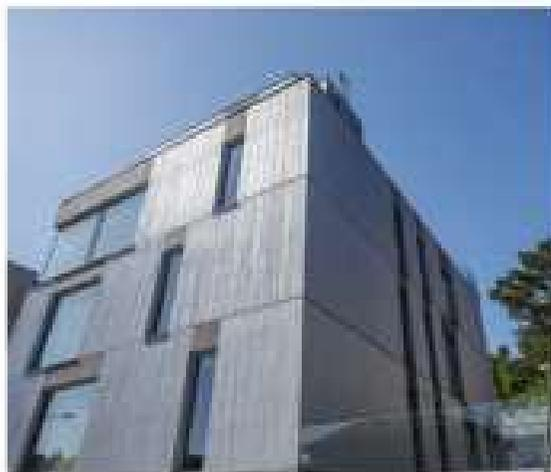
**KONSTRUKTION DER WOHNUNG:** Die tragende Struktur des Hauses besteht aus einem monolithischen Stahlbetonskelett und tragenden geschnittenen Porotherm-Ziegeln. Alle vertikalen Strukturen in den Wohnungen werden mit Putz, Gipskartonplatten-System und anschließendem Anstrich versehen. Die Wohnräume haben eine lichte Höhe von 3.000 mm.
